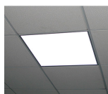
УСТАНОВКА В "АРМАСТРОИ"
